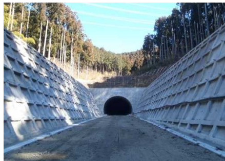
引田側坑口部開通間近の松坂トンネル
