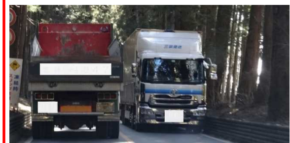
全線にわたって車道幅員が狭いことから、大型車同士のすれ違いが困難である。
