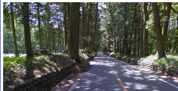
杉が路側にはみ出ており、道路幅員を阻害しているため、車両同士のすれ違い時に危険である。
