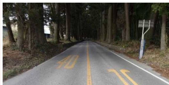
歩道もないうえ照明も設置されていないことから、夜間交通時に極めて危険性が高い。
