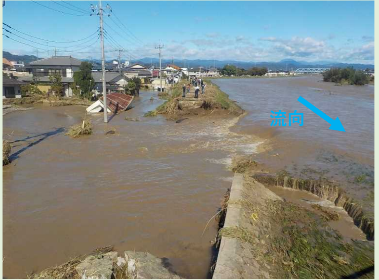
海陸橋上流右岸の被災状況（令和元年10月13日午前10時）
