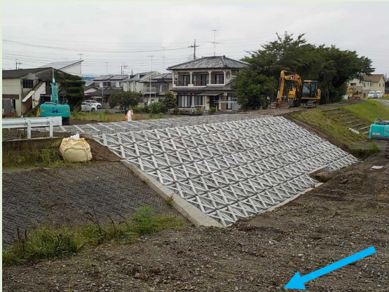
大橋応急工事実施状況（令和2年7月10日時点）
