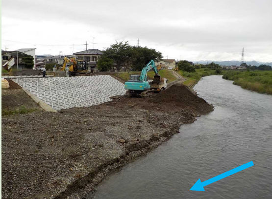
大橋上流土砂撤去状況（令和2年7月9日撮影）
