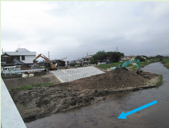
大橋応急工事実施状況（令和2年6月26日時点）
