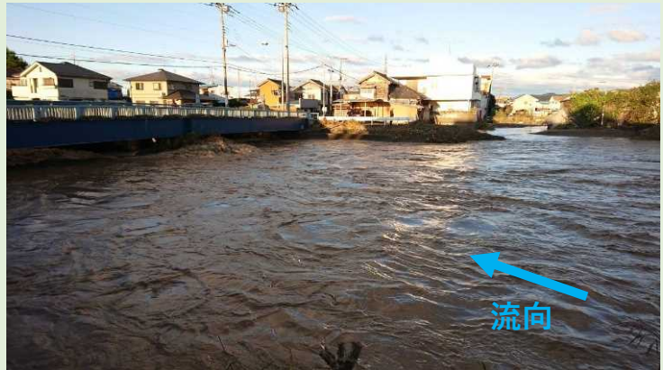
大橋上流右岸の被災状況（令和元年10月13日午前6時）
