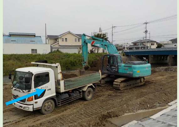
大橋上流土砂撤去状況（令和2年7月9日撮影）
