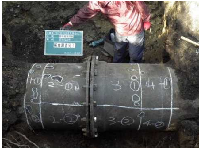
埋設管路の劣化診断調査
