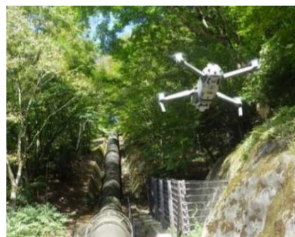
ドローンを使用した保守管理
