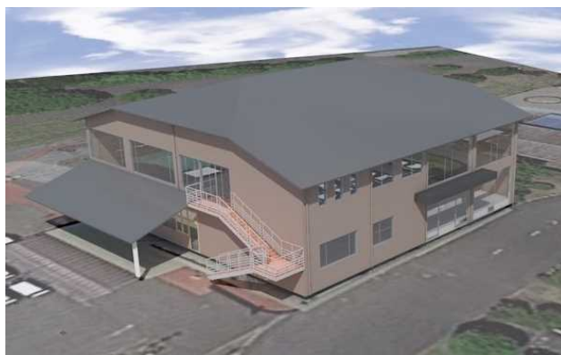
クラブハウス塗装修繕後イメージ
