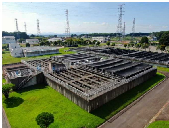
浄水・配水施設(薬品沈澱池・配水池)
