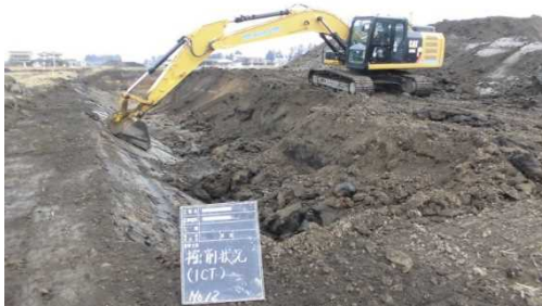
（芳賀遊水池整備工事で発生した建設発生土）
