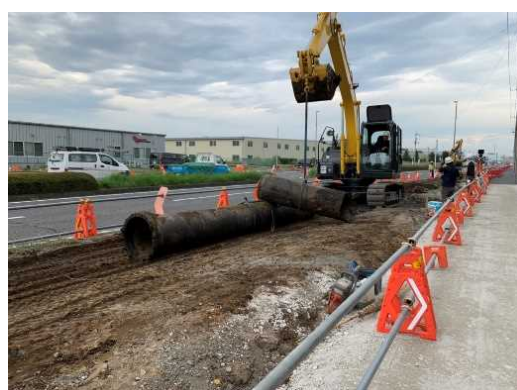
既設配水管撤去
