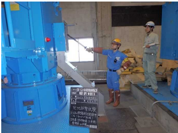
設備の更新工事などを発注します (鬼怒水道事務所)
