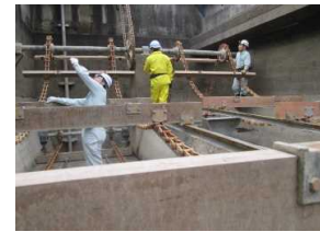
北那須水道事務所の排水池
