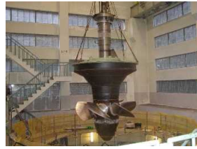
風見発電所で吊り出した水車
