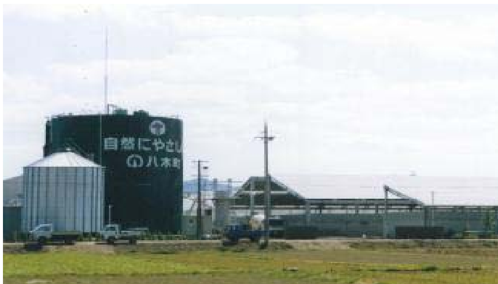
京都府八木町 畜産バイオマスエネルギー利用施設
