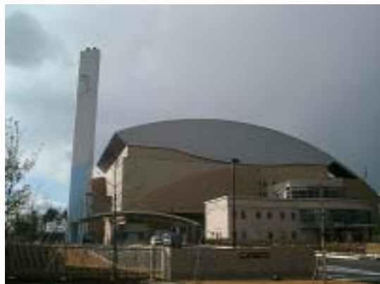
ごみ発電を導入した「クリーンパーク茂原焼却ごみ処理施設」
