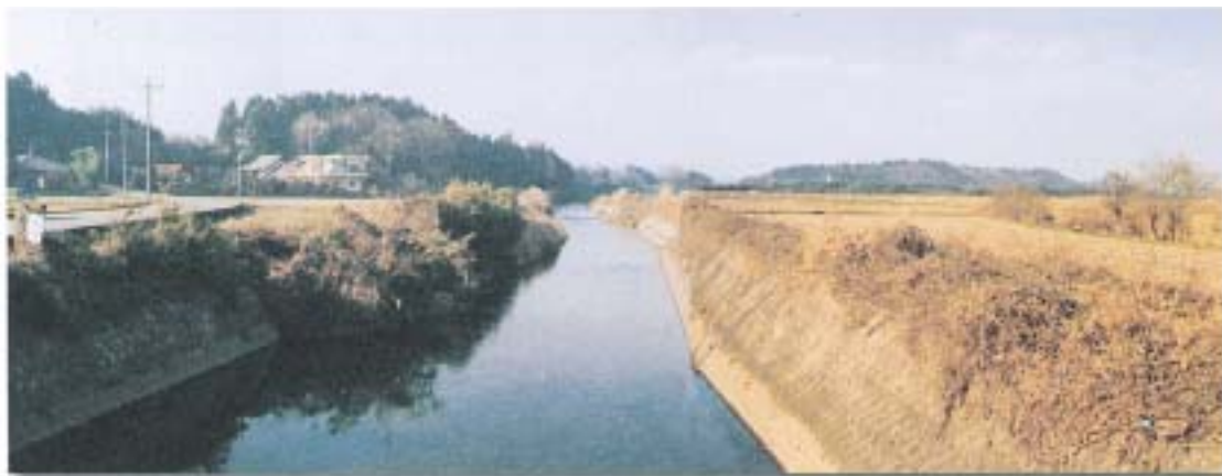
施工前（工事前は堤防にコンクリートの見える川であった）
