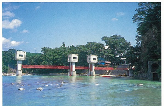
西岩崎頭首工
