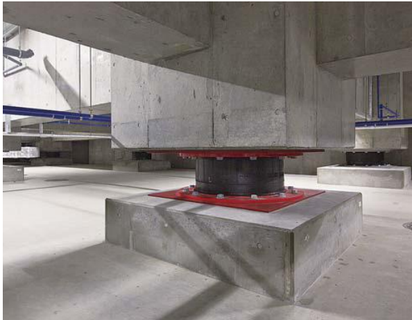
免震構造（117基設置）
