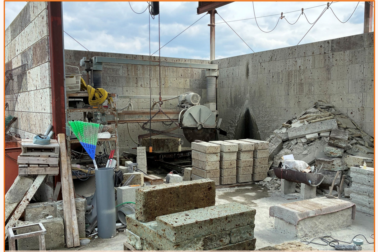
古材の大谷石を加工してもらっている様子
