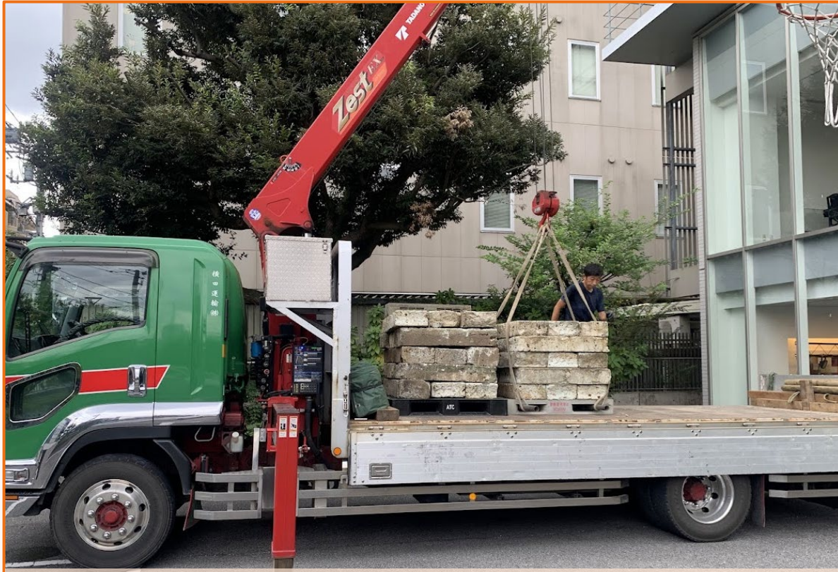
古材の大谷石を運搬してもらっている様子
