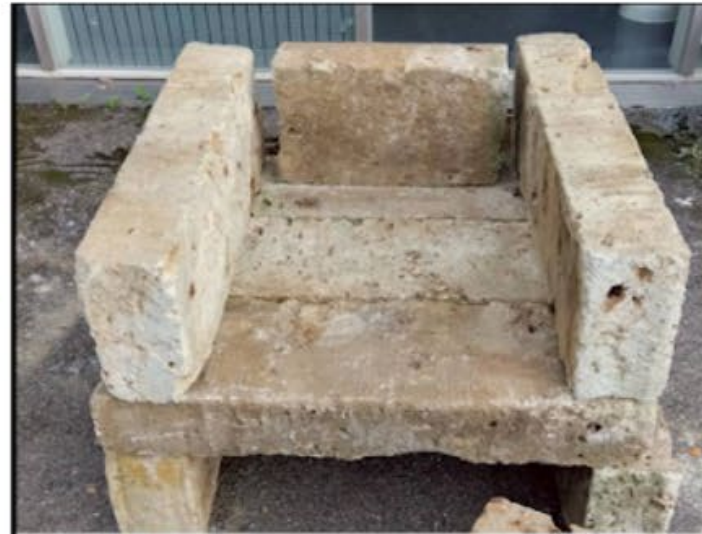
②側壁の組み立て
