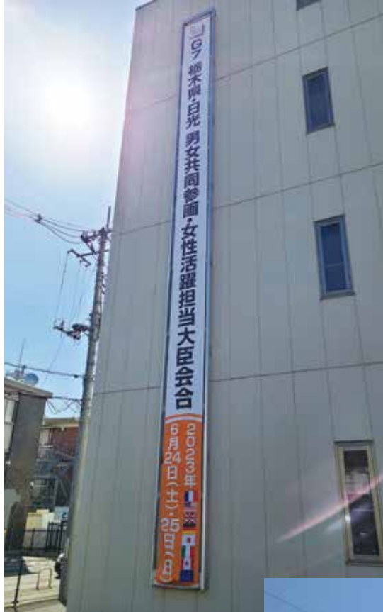
県庁舎北別館
