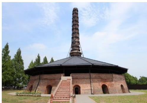
野木町煉瓦窯（野木町）
