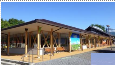
道の駅友愛の森 農産物直売所新築工事
