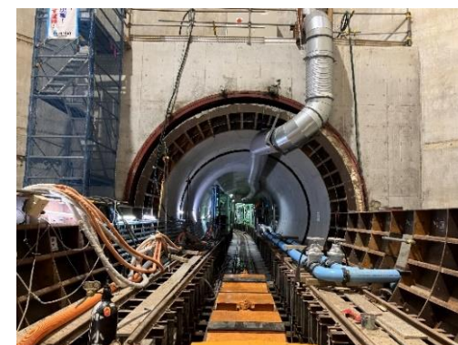
▲ 浸水被害軽減のため整備中の地下捷水路（栃木市 巴波川）
