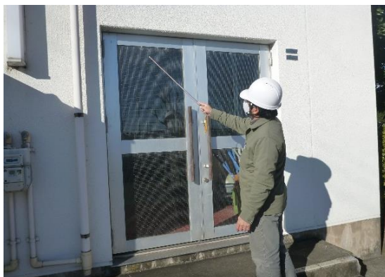
定期点検・劣化度診断の実施
