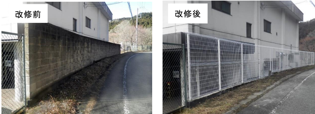
非構造部材の耐震対策（ブロック塀の改修）
