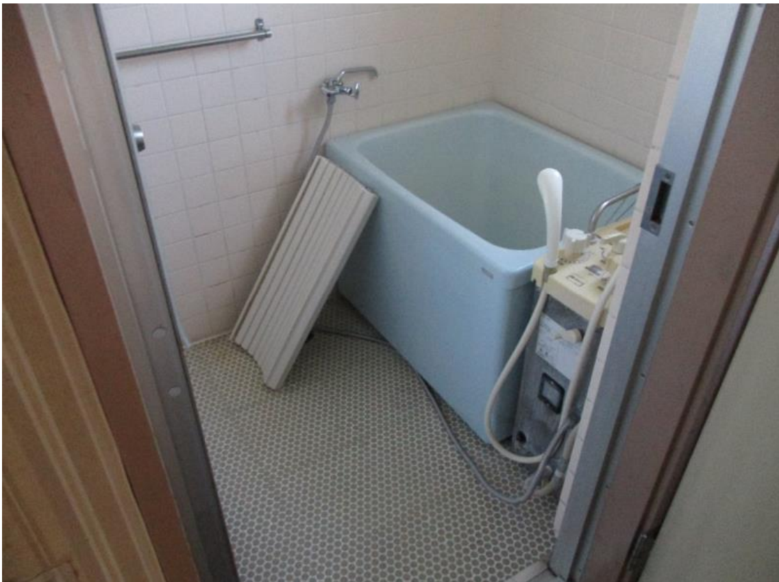
建物内にて撮影（浴室）
