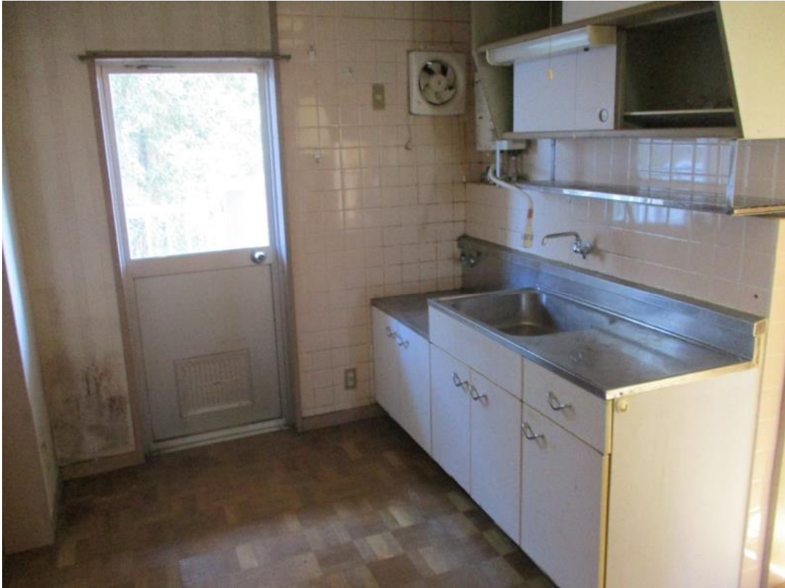
建物内にて撮影（キッチン）
