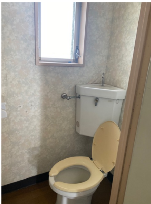
建物内にて撮影（トイレ）
