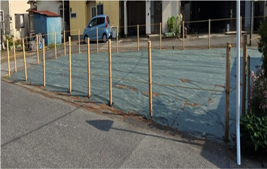
北西側から南東側を見て撮影
