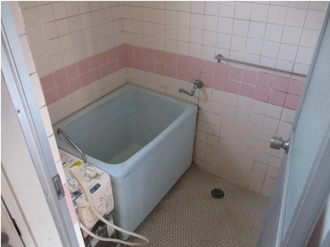
建物内にて撮影（浴室）
