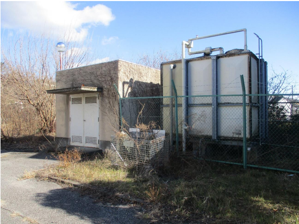
敷地東側（ポンプ室受水槽）
