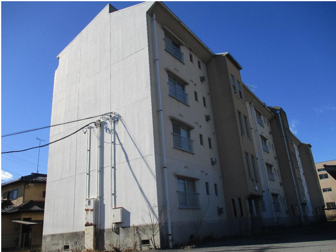
東側から南西側を見て撮影
