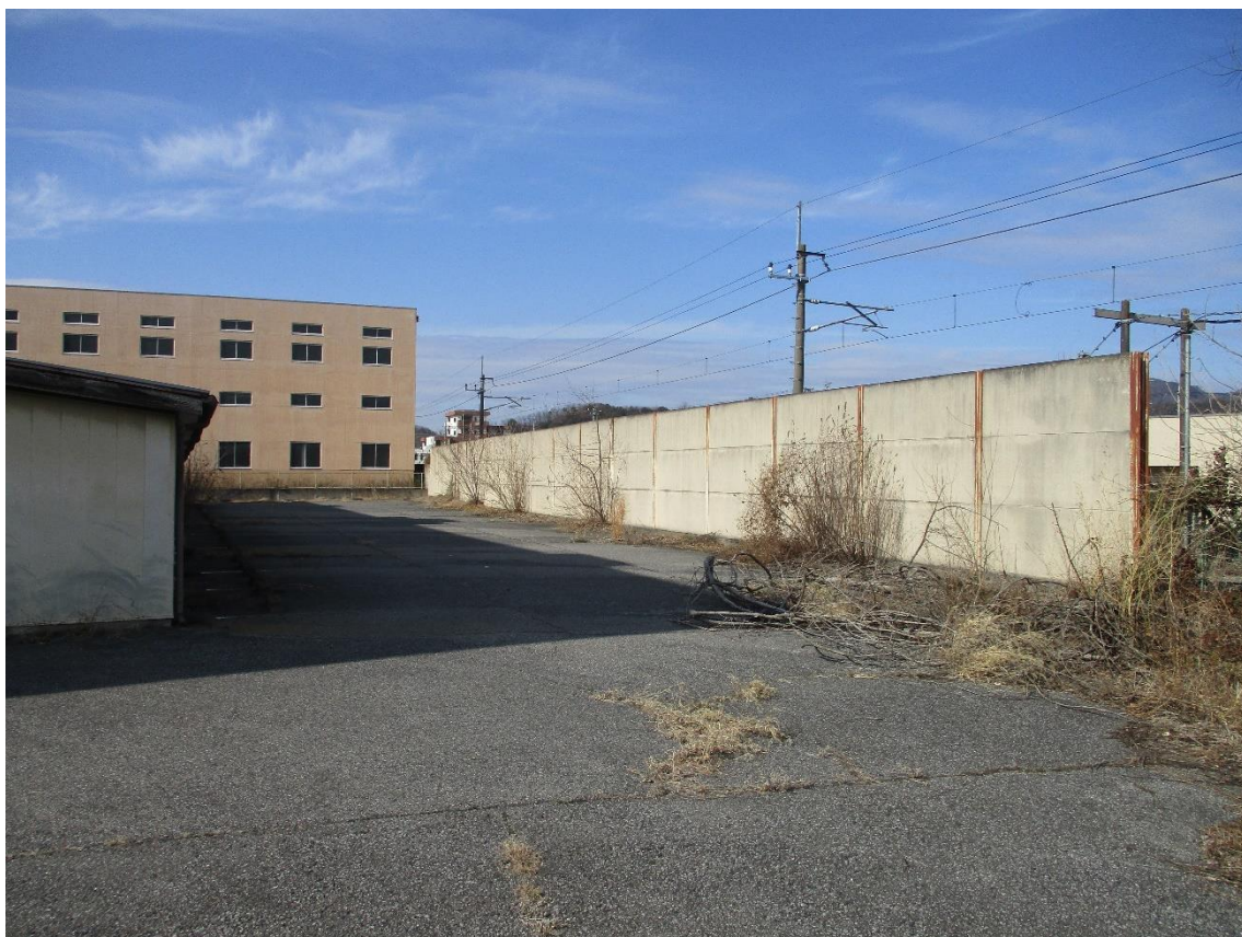
敷地内北側（防音壁）
