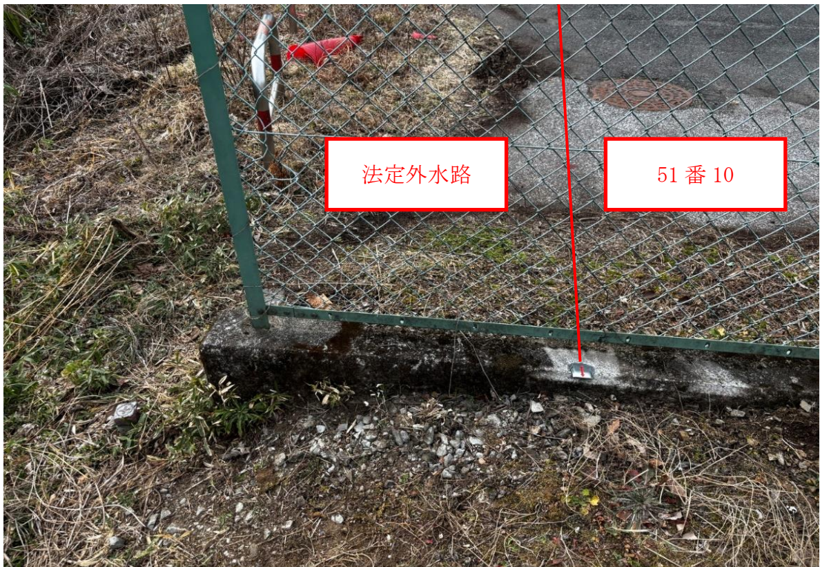
南東側を撮影（南側越境部）
