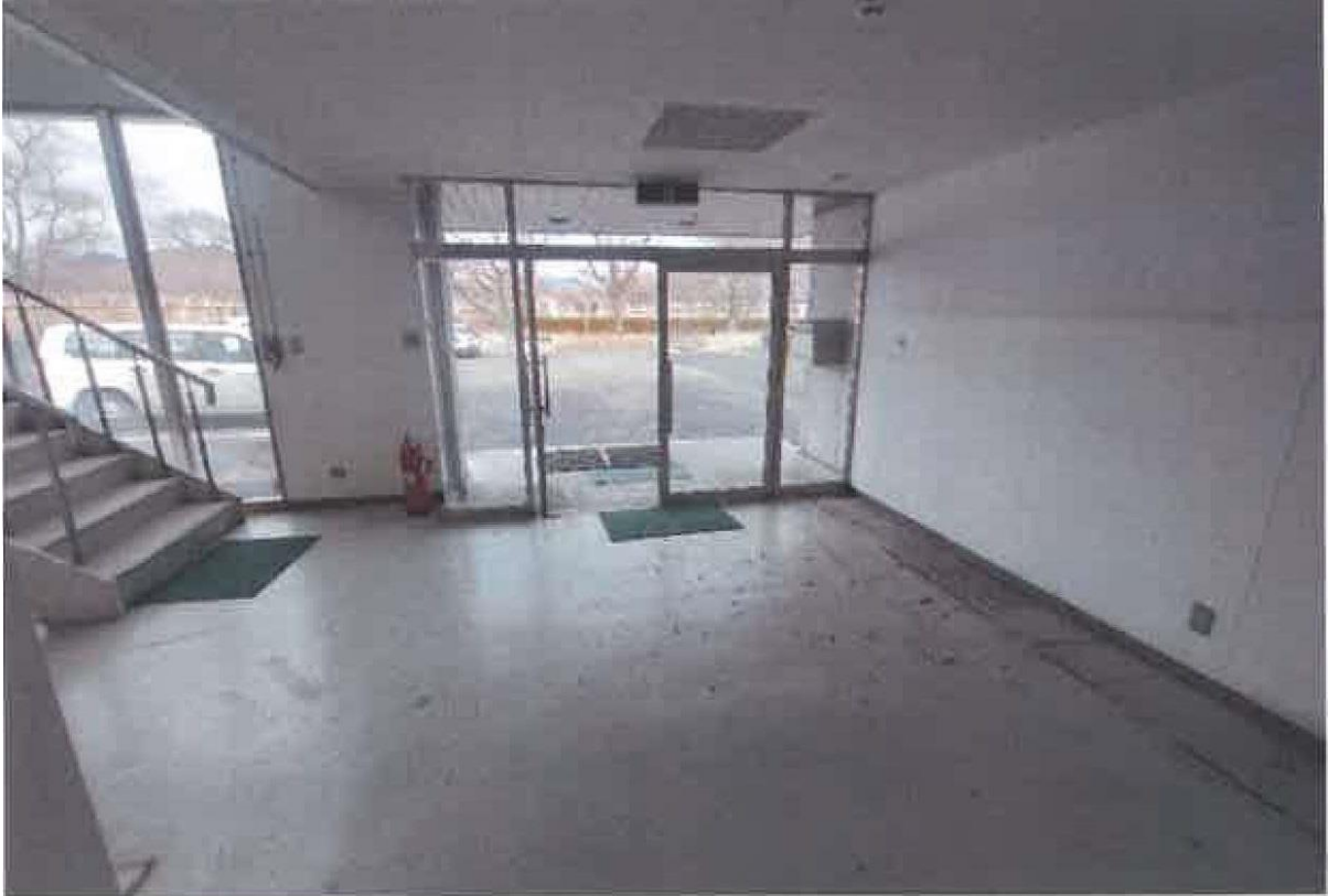
建物内にて撮影（玄関ホール）
