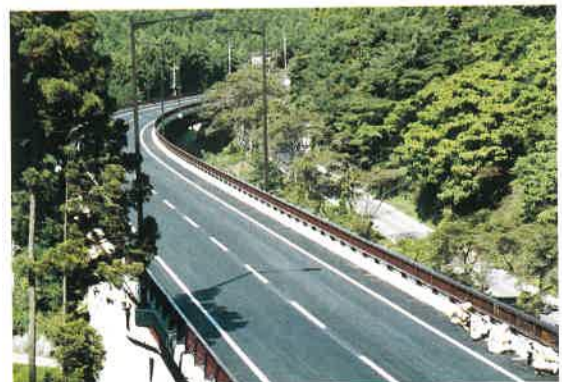
●急勾配を緩和するための高架橋
