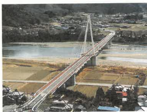
●周辺の景観にも配慮した美しい斜張橋
