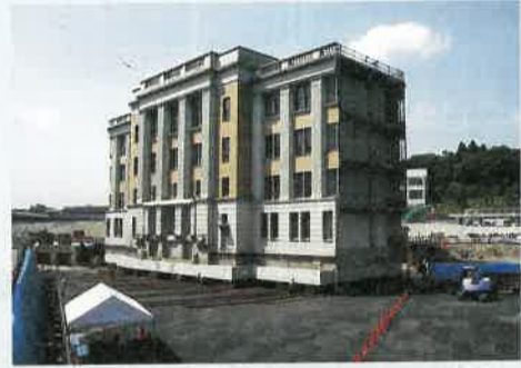
移動部分は高さ21m、幅約43m、奥行き約21m、重さは約6000トンのです
