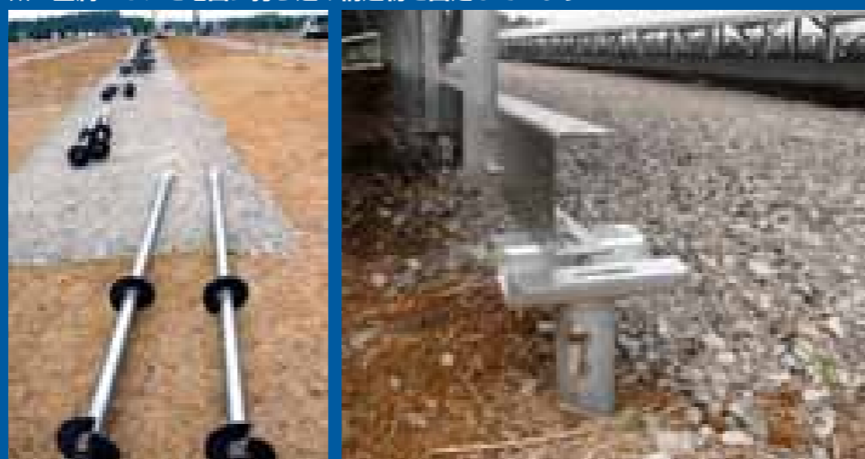
太い金属パイプを地面に打ち込み構造物を固定しています
