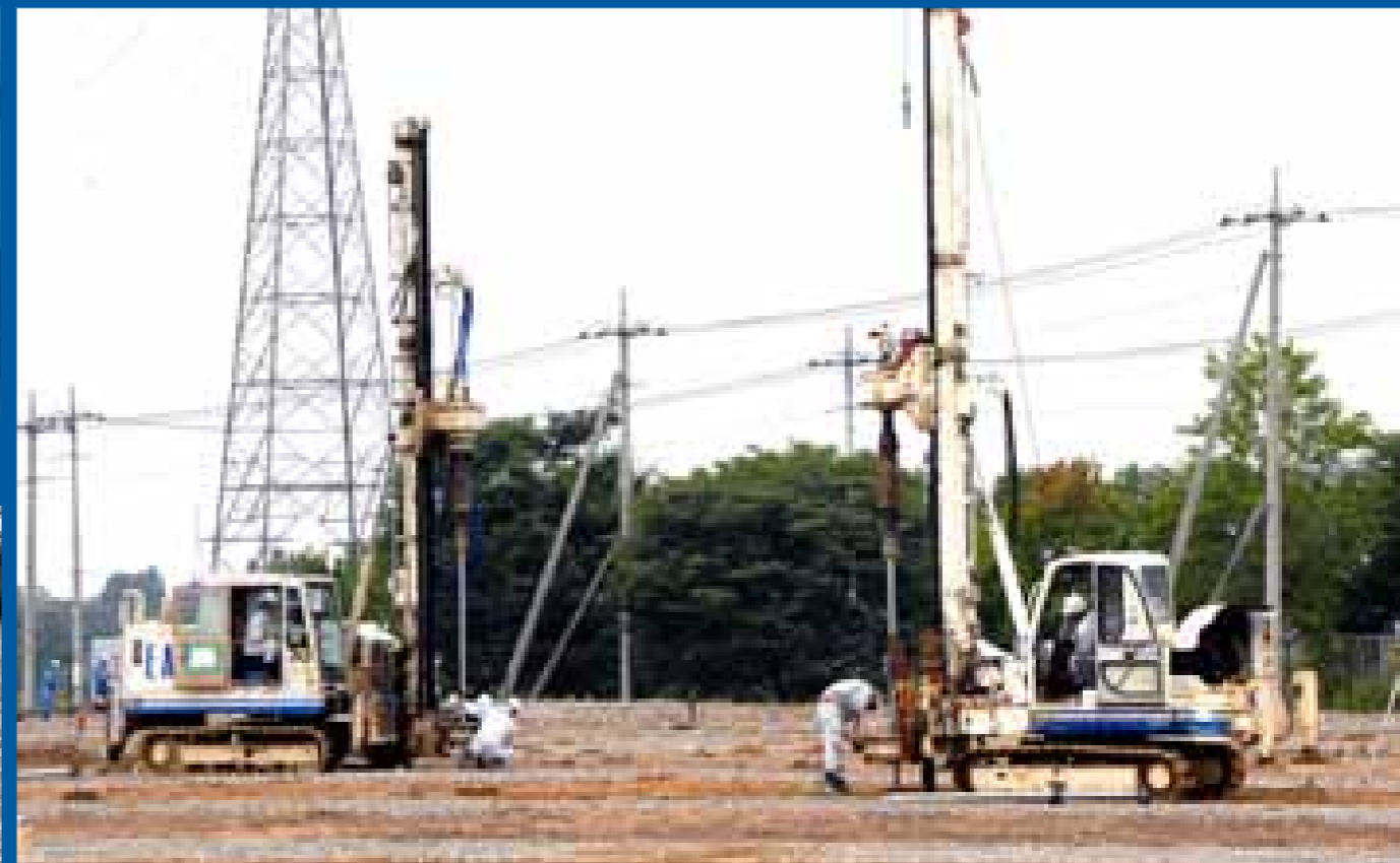
基礎工事にはコンクリートを使わず、長さ約3mの金属パイプを地面に打ち込み、構造物を固定します
