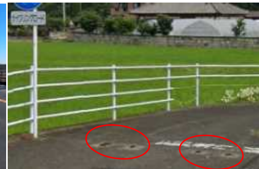
写真2_車止め基礎の存置
