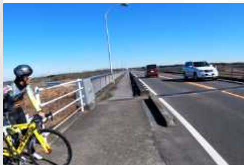
写真1_橋梁部の確認
