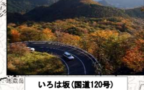
いろは坂(国道120号) (日光市)
