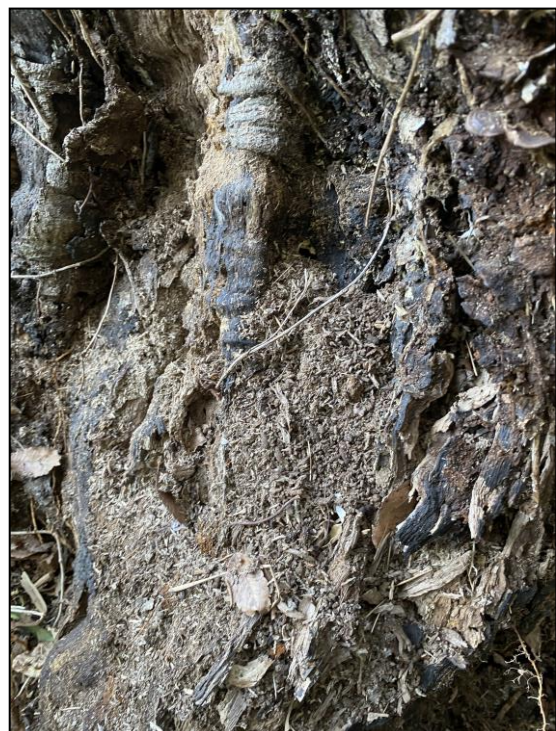
崩壊が進みおがくずのようになっている部分も目立つ。
