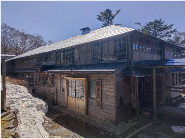
三斗小屋温泉大黒屋旅館本館
