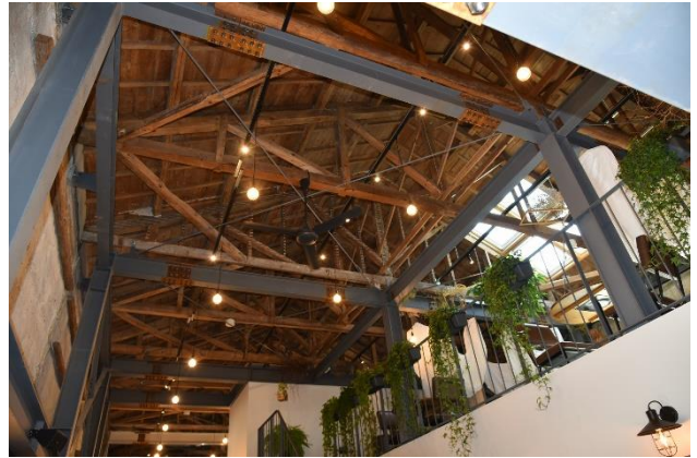
旧吉田村農業協同組合西倉庫 (吉田村 Village 西棟)内観
