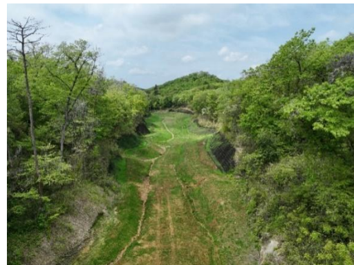
▲復旧作業後の全景
