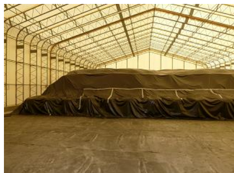
溶融スラグ等の保管(テント内部)
