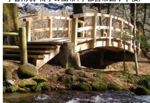
とちぎ材での木橋の整備支援(塩谷町)
