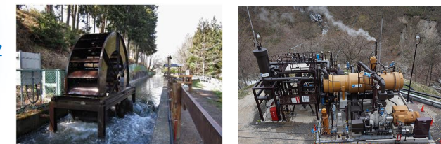
「小水力発電による電力を集落に供給」「地熱発電による熱電供給」
