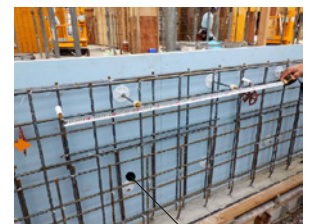
押出ポリスチレンフォーム 厚30mm（断熱材）
