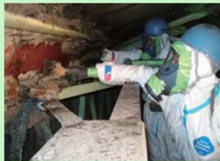
吹付け石綿の除去作業の様子
