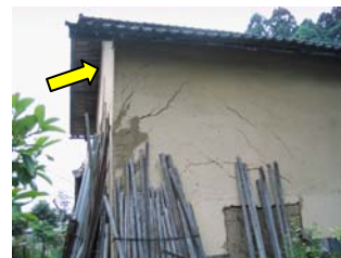
倉の屋根の隙間も侵入口に・・・
