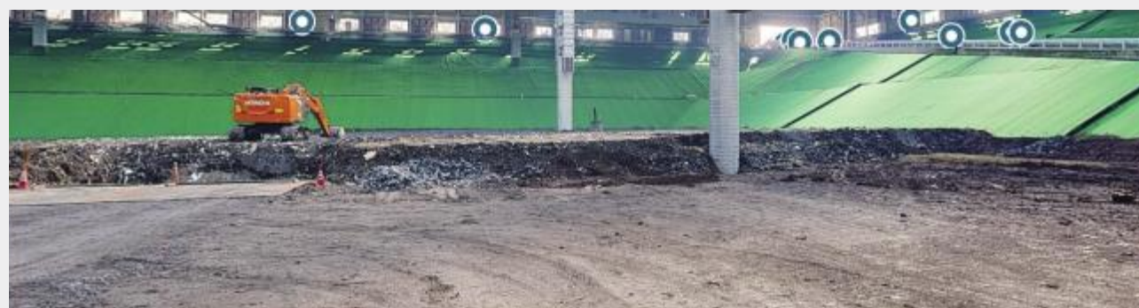
被覆施設棟のVRツアー
