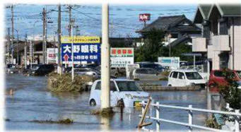
豪雨による浸水被害
