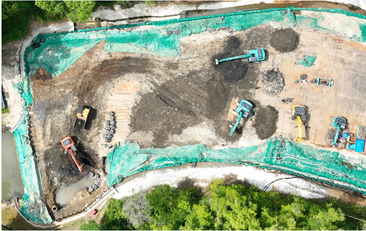
不法投棄地の掘削の状況
