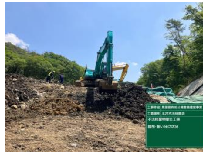
掘削・振るい分け状況
