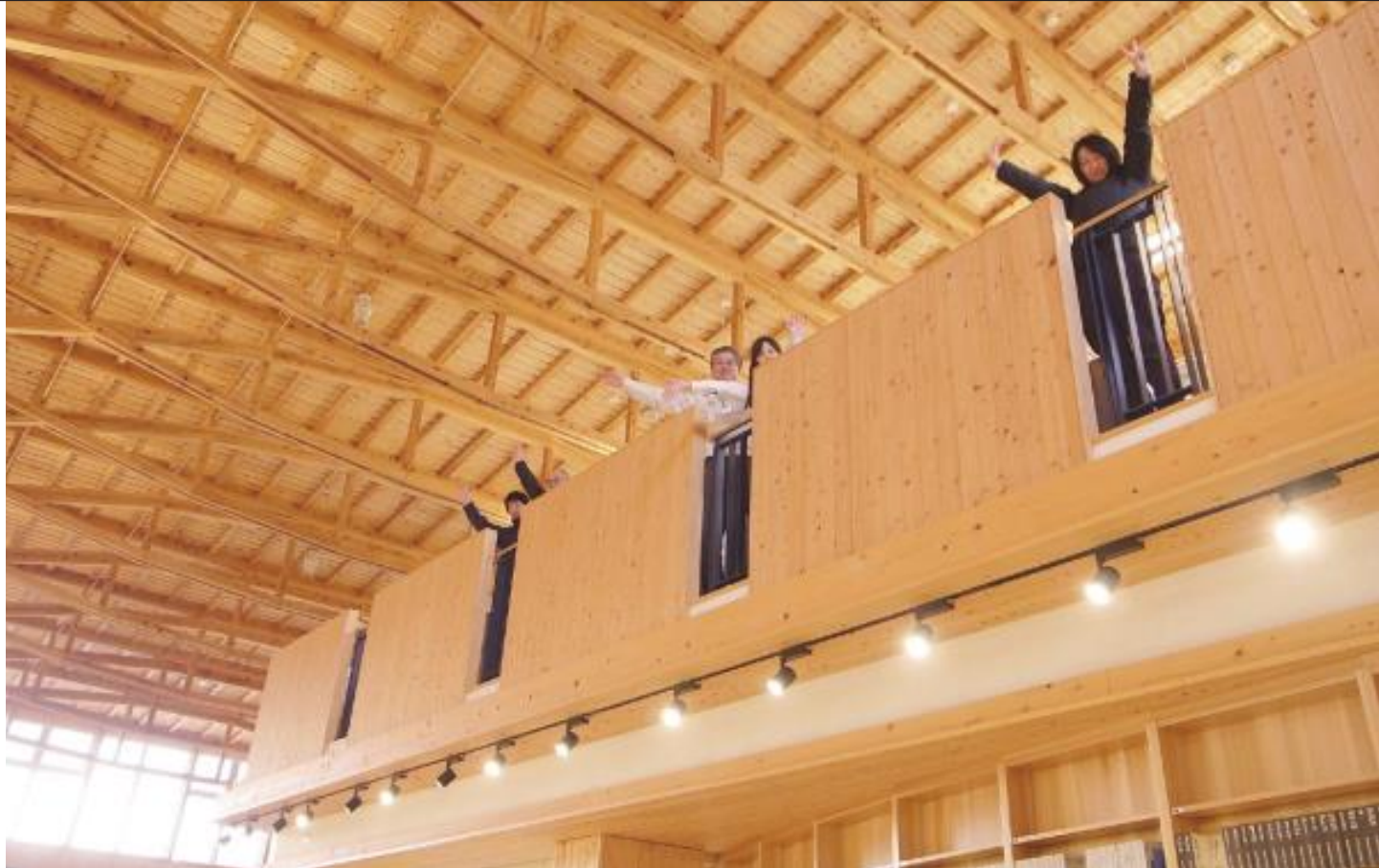
図書館の大空間を柱も金具もなく支える「連接サスペンスアーチ構造」。木造軸組工法の力強さ、美しさが際立つ
