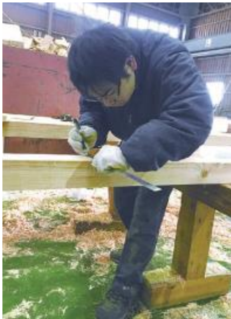
上: 中大規模の木造建築物はデザイン性重視で材も大きいので、それに対応できるよう、機械と手加工を組み合わせている 下: 手加工を行う若手の職人が常駐している
