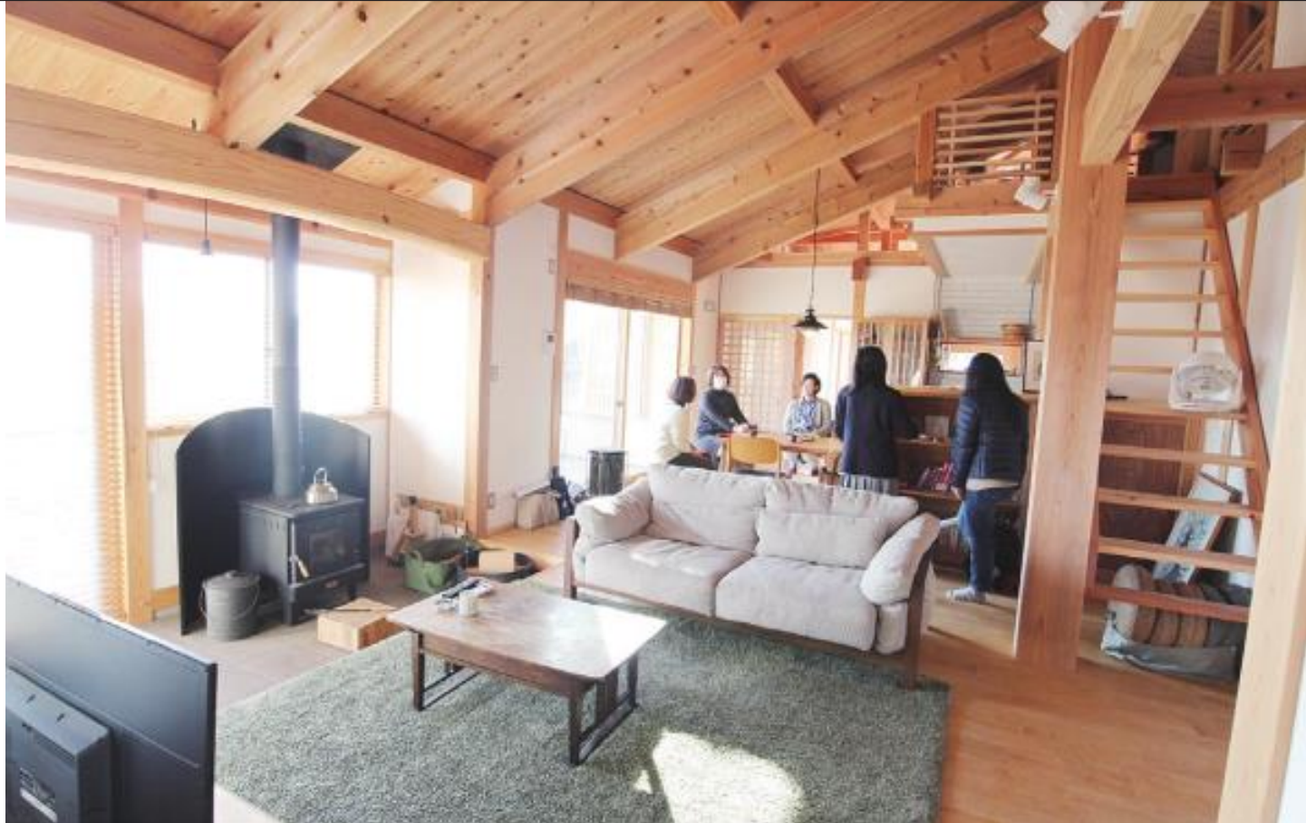
木を現しにした木組みの空間が印象的。天井・梁・床・建具など、場所に応じて木目の表情を使い分け、漆喰がそれらのつなぎ役を果たしている
