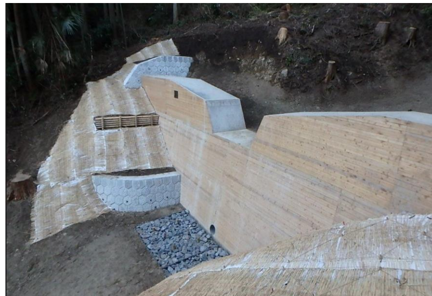
残置式間伐材型枠 関山 (那須町)
