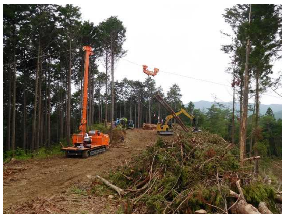
タワーヤードを活用した集材作業
