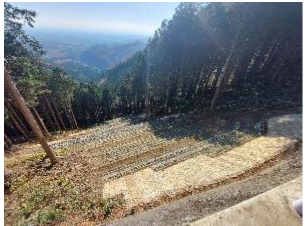
復旧工事の完了状況（那須塩原市 一の沢上流）
