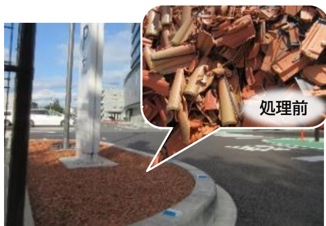
廃瓦を破碎処理して化粧材として再利用
