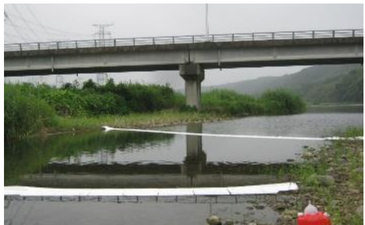
異常水質事故の対応（オイルマットの設置）
