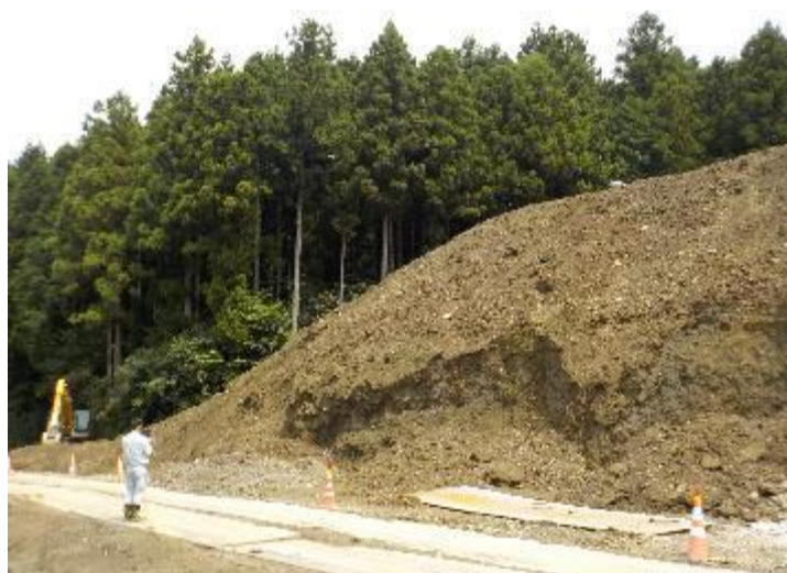
ドローンによる不法盛土の測量
