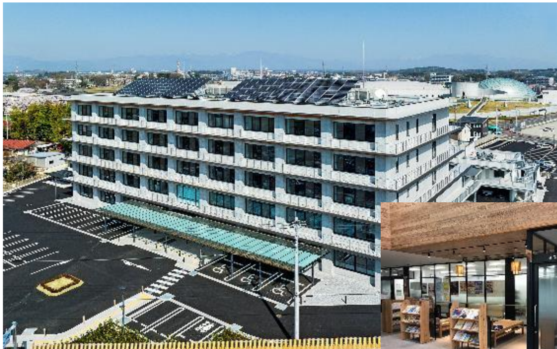
那須庁舎全景（令和5（2023）年3月供用開始）
