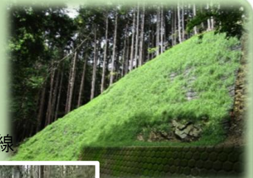
緑化工による 法面改良
