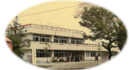
昭和 42 年 4 月 竣工時
