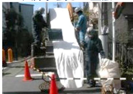
パルテムSZ工法
