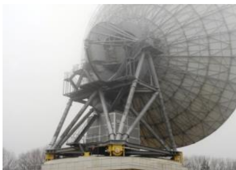
国立天文台パラボラアンテナメンテナンス
