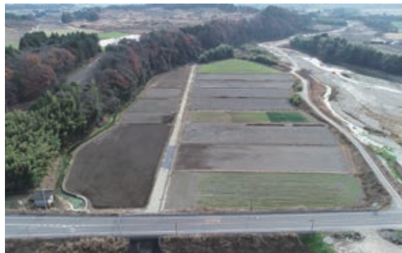
写真4 復旧後の農地
